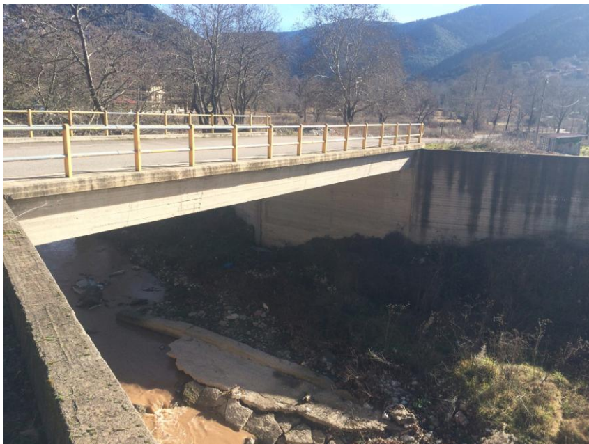
Εικόνα 2: Γέφυρα Κλαυσίου (Σχέδιο Γ-1).
